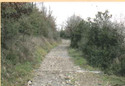
Chemin restauré, à Lignerolles. CSA E.W.
